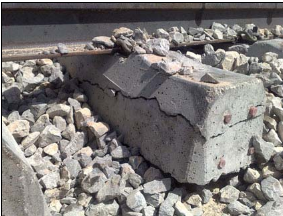
تصویری دیگر از تراورس‌های بتنی پس از عبور قطار
